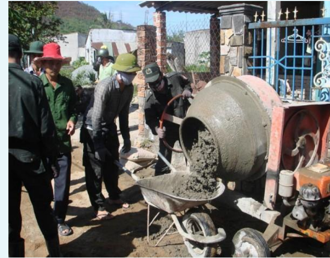
Bùn bê tông lấy từ công trường xây dựng
