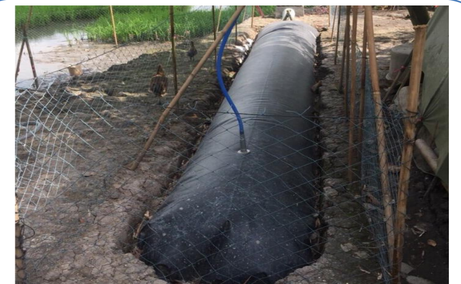
Mô hình túi ủ biogas HDPE xử lý chất thải chăn nuôi heo
