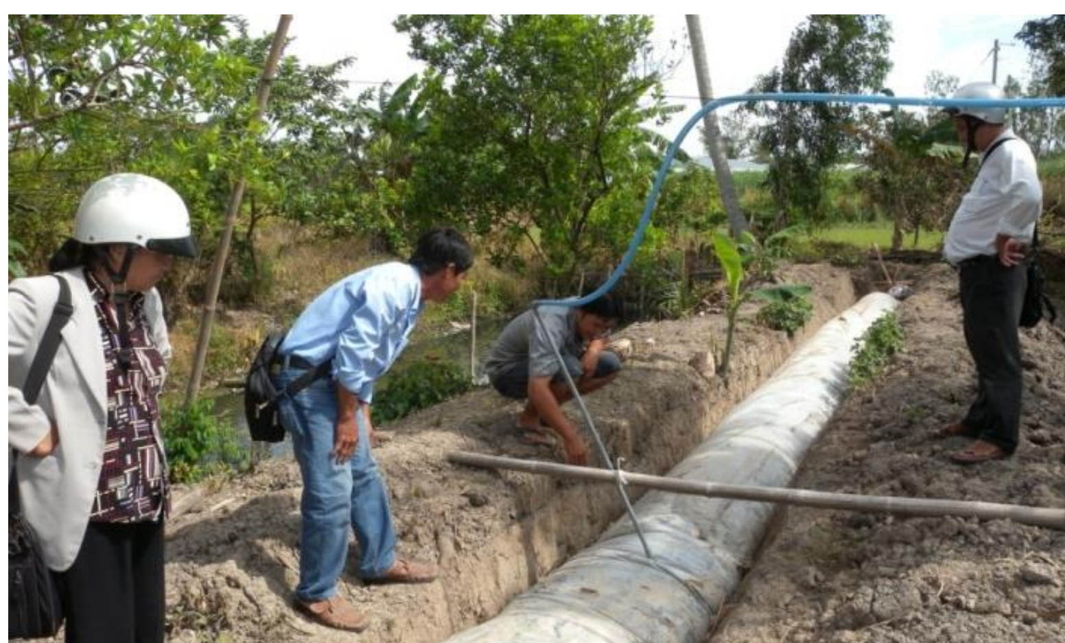
Mô hình túi ủ biogas PE xử lý chất thải chăn nuôi heo
