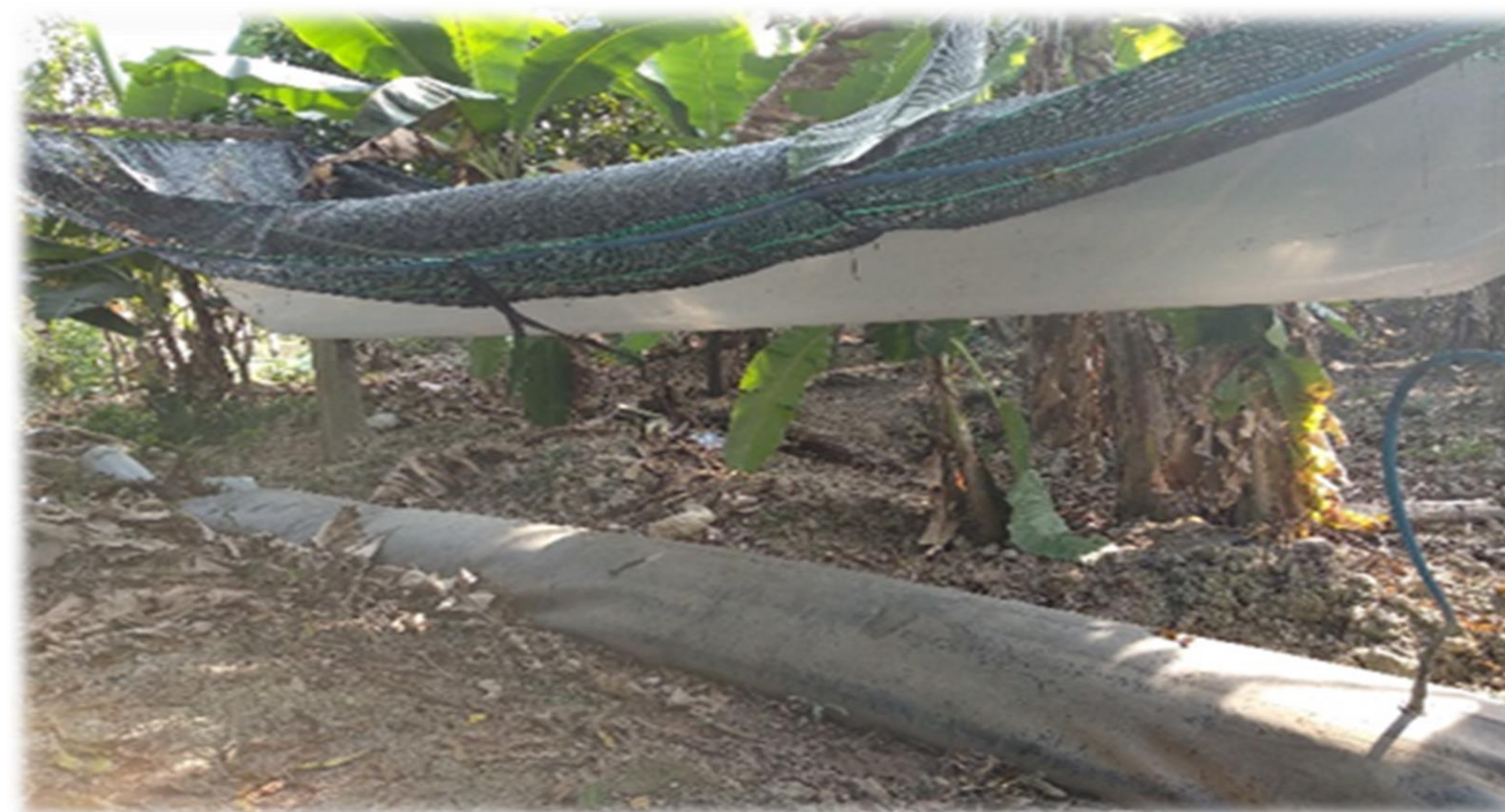
Mô hình túi ủ biogas HDPE xử lý chất thải chăn nuôi heo và chất thải hữu cơ hộ gia đình
